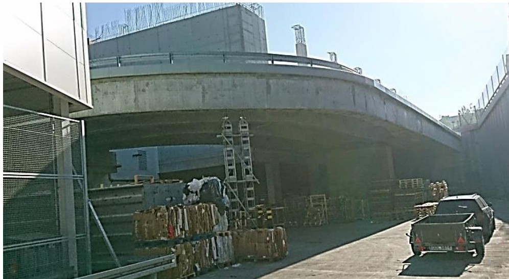
Rys. 5 Widok ugiętej i podpartej rampy.
